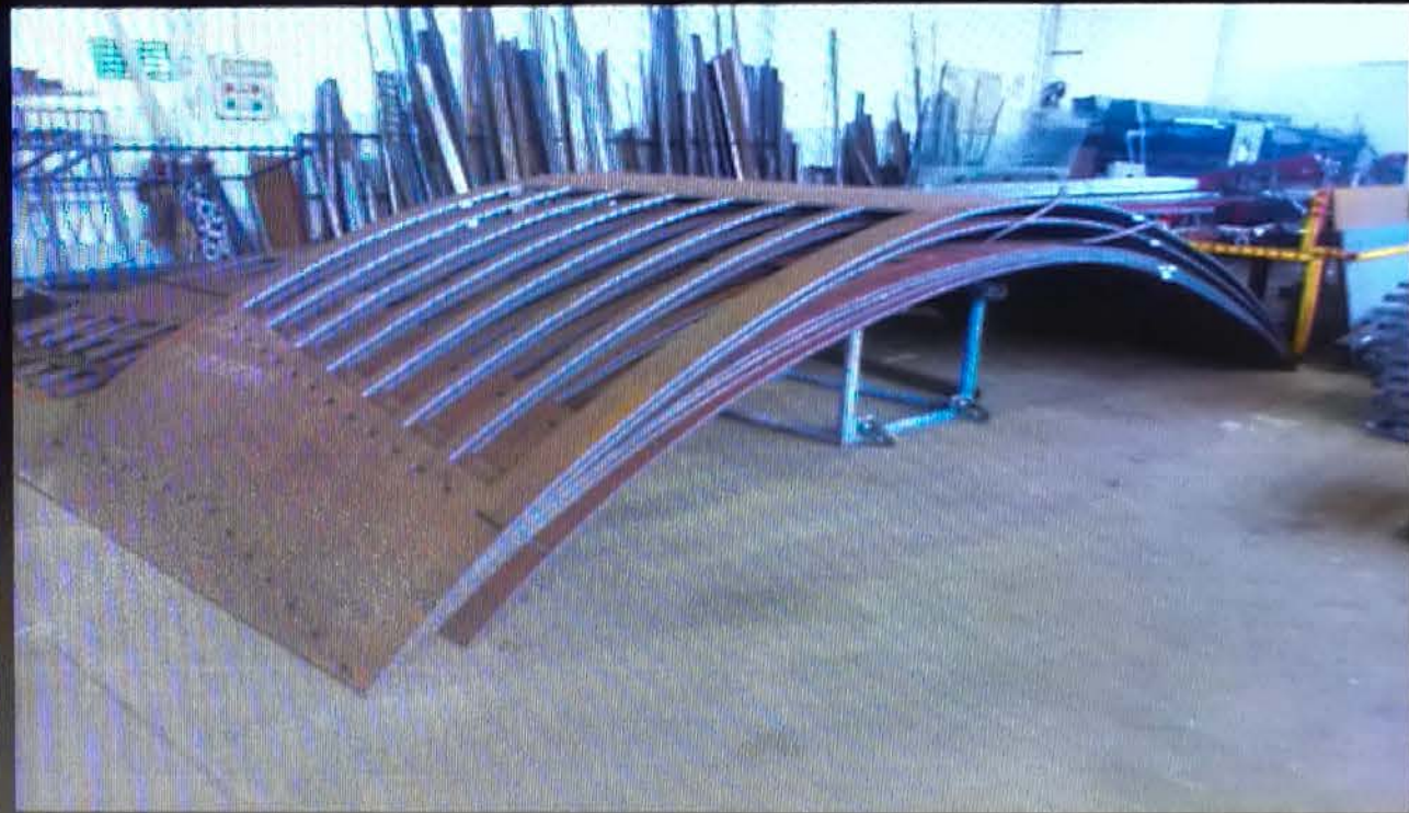
模型指导钢结构深化加工
