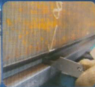
坡口角度检查
