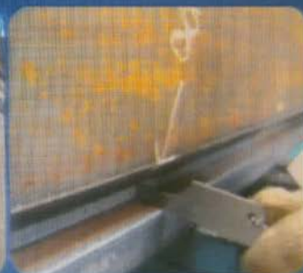
坡口角度检查
