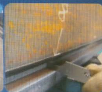
坡口角度检查
