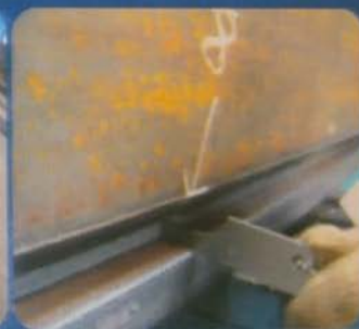
坡口角度检查
