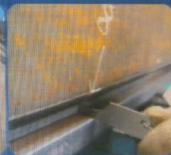
坡口角度检查
