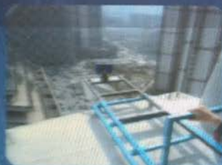
塔楼外框扫描作业
