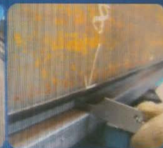
坡口角度检查
