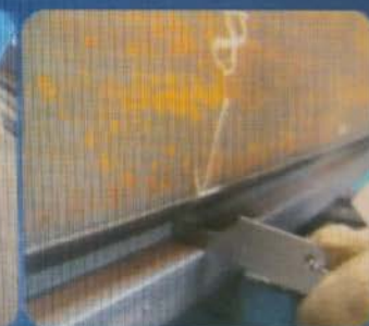
坡口角度检查
