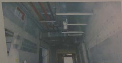
L7层核心筒走廊区域-实体
