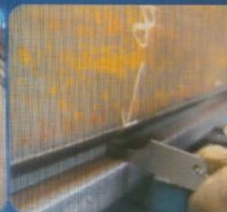
坡口角度检查
