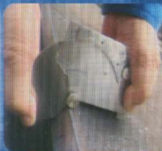
坡口角度检查
