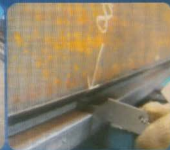
坡口角度检查
