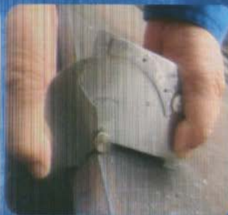
坡口角度检查
