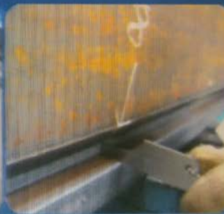
坡口角度检查
