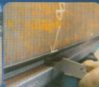
坡口角度检查
