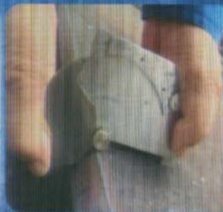
坡口角度检查
