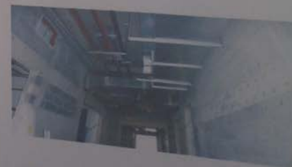
L7层核心筒走廊区域-实体
