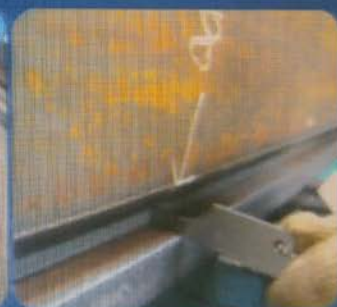
坡口角度检查
