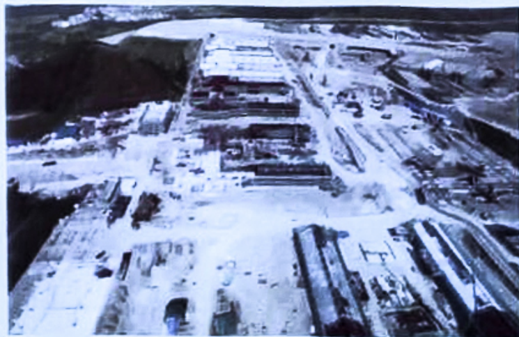
无人机技术现场平面管理
