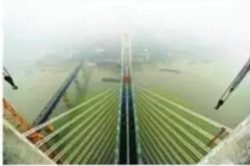
图 1：渝黔铁路新线白沙沱长江特大桥
